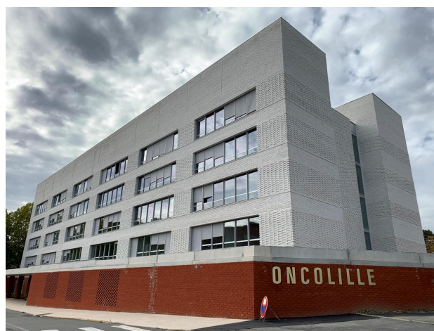
Locaux de l'institut OncoLille
